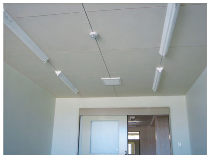
小学校図書室書庫 (天井)
